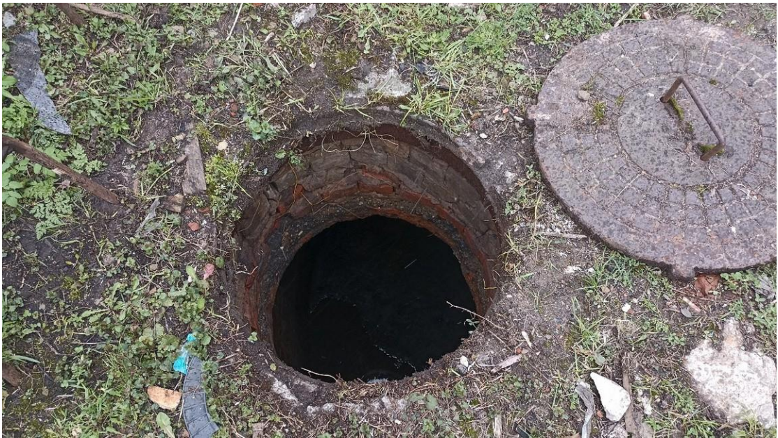
Ил. 19. г. Городец, ул. Михеева, д.14/3. Участок проектируемого строительства. Люк резервуара.
