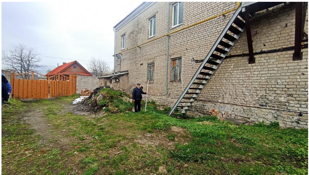
Ил. 17. г. Городец, ул. Михеева, д.14/3. Вид с севера. Участок проектируемого строительства. Точка фиксации 5.
