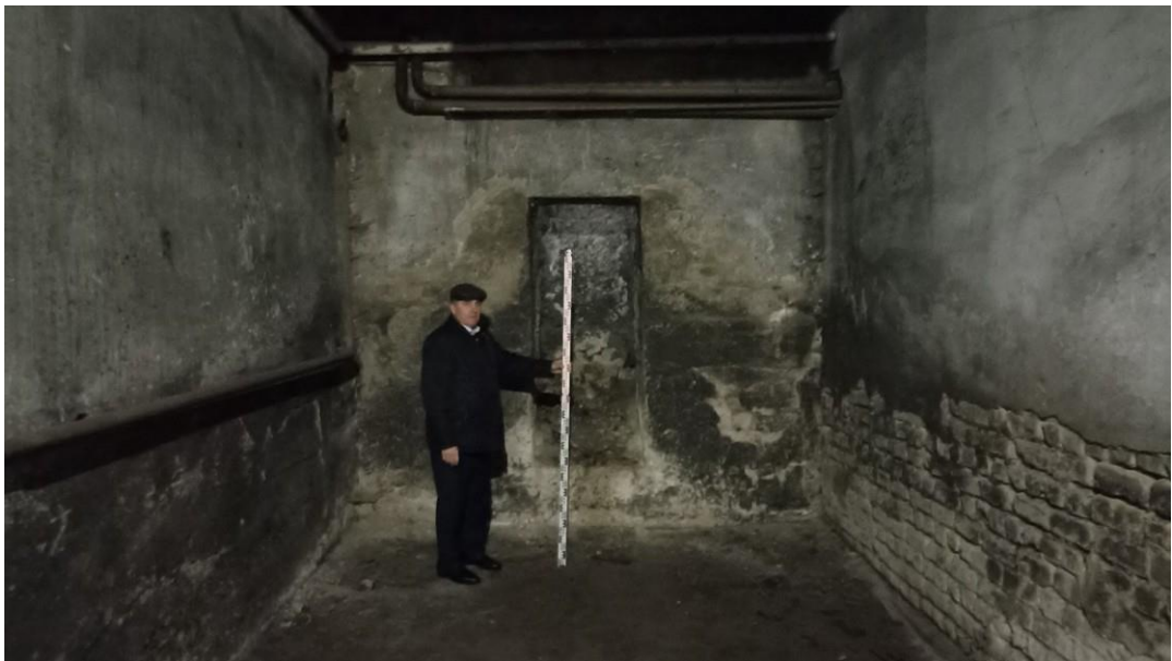
Ил. 21. г. Городец, ул. Михеева, д.14/3. Внутри подвала. Вывод коммуникаций.
