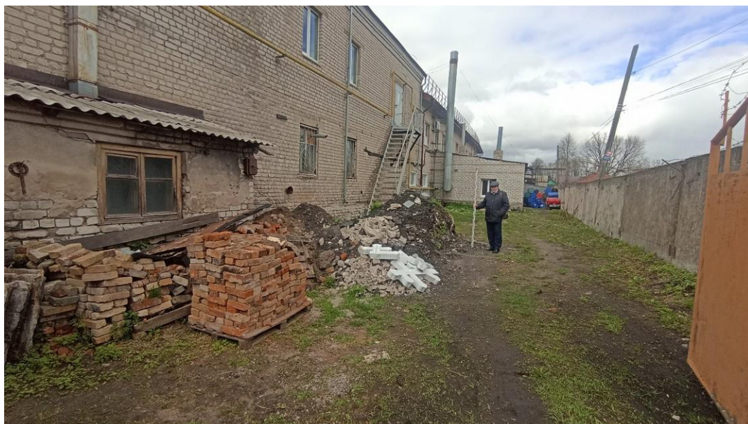
Ил.15. г. Городец, ул. Михеева, д.14/3. Вид с юга. Участок проектируемого строительства. Вход в подвал планируется демонтировать, стройматериалы и строительный мусор вывезти. Точка фиксации 4.
