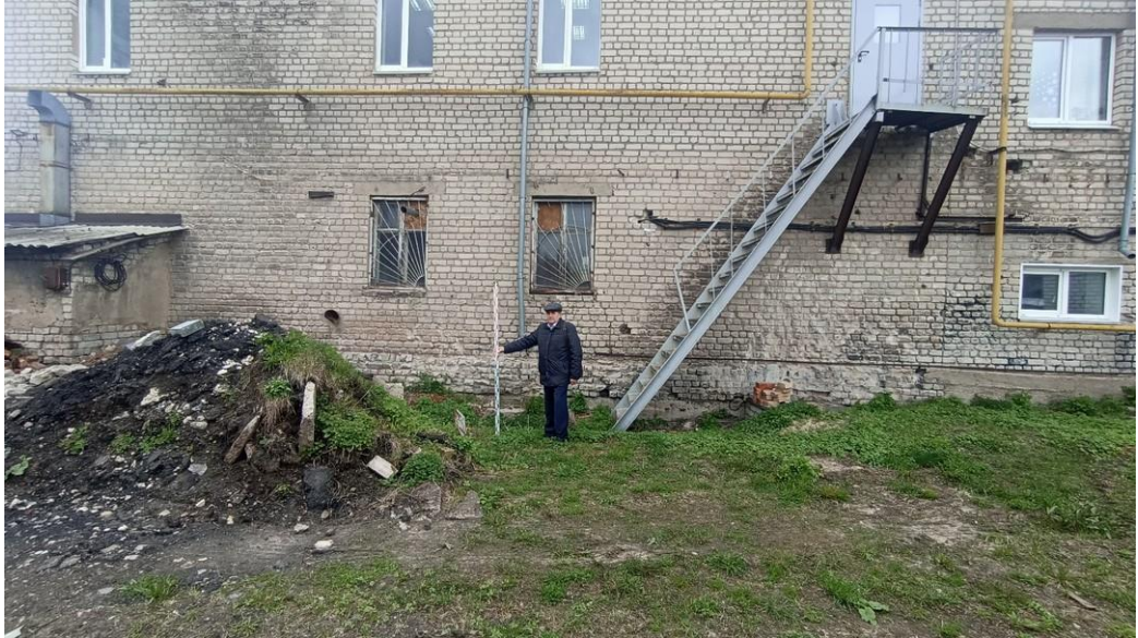
Ил. 16. г. Городец, ул. Михеева, д.14/3. Вид с востока. Участок проектируемого строительства. Справа под лестницей заложено окно подачи угля в подвал с котельной. Слева на стене черный след – место разобранной кирпичной трубы котельной. Точка фиксации 4.
