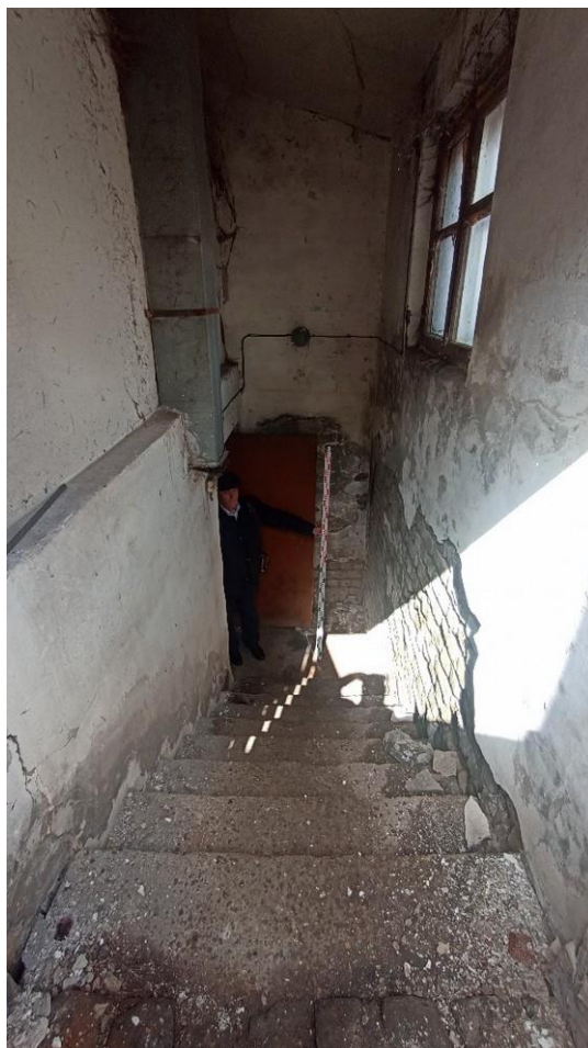
Ил. 23. г. Городец, ул. Михеева, д.14/3. Лестница в подвал. Планируется демонтировать лестницу.
