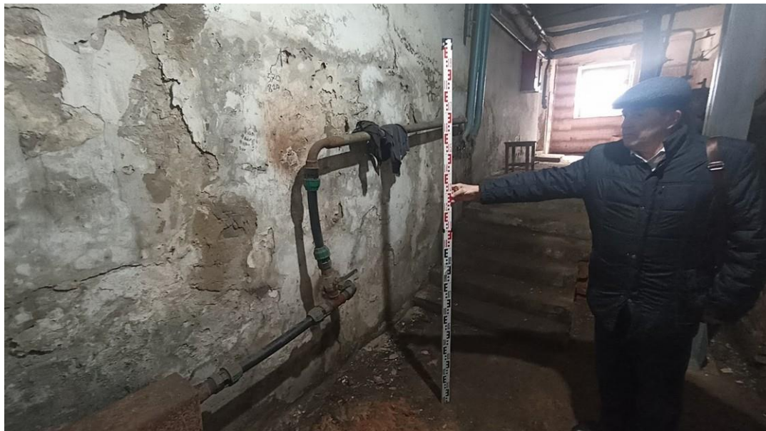
Ил. 22. г. Городец, ул. Михеева, д.14/3. Внутри подвала. Вывод коммуникаций.
